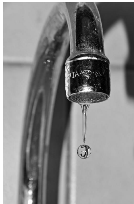
בתמונה: חסכם (וסת ספיקה) מותקן על ברז 107
